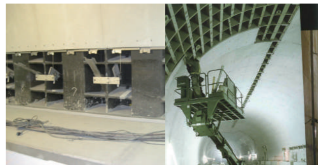
【図2】トンネル耐火板取付け
