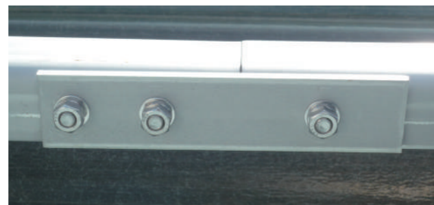
【図 1】従来の部材接合状況
